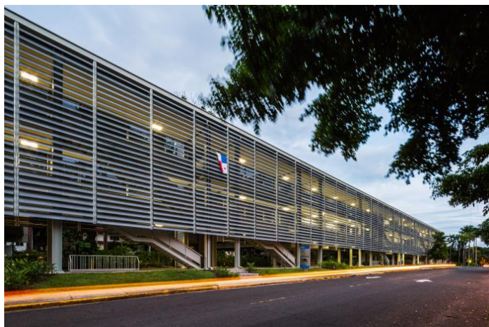
Figura 88 | Vista Acesso em estrutura metálica
