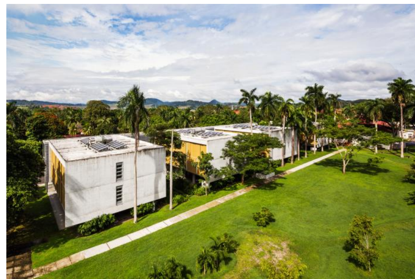
Figura 121 | Vista Concreto Armado aparente (Fonte:
