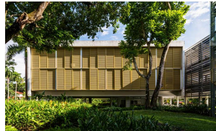
Figura 116 | Vista Varandas Painéis corrediços (Fonte:
