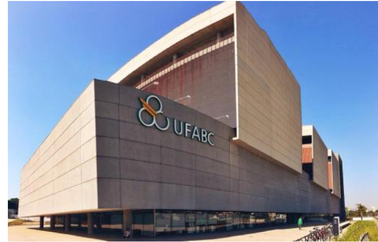
Figura 163 | Foto da fachada
