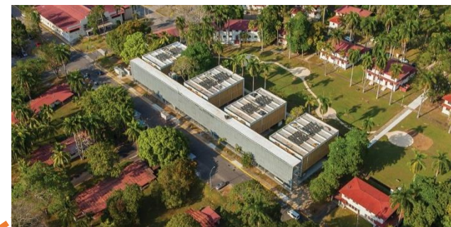
Vista área Alojamentos
